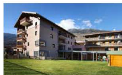
12 logements en accession sociale à la propriété, une halte-garderie et un pôle social (Aime/Savoisienn Habitat).
